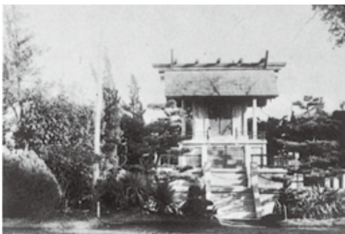
正門横の奉安殿（天皇・皇后両陛下の御真影が安置され、校内への入出時に必ず礼拝した）
