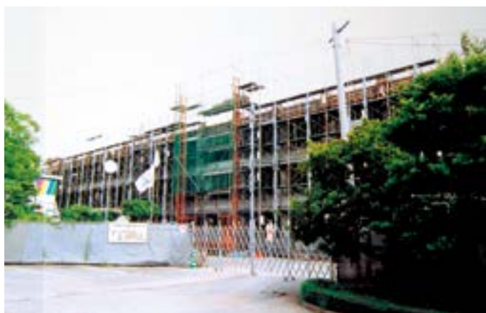
校舎工事 (平成 14 年アルバム)
