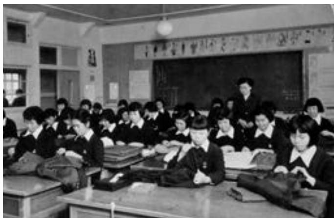
家庭科実習風景（昭和33年アルバム）
