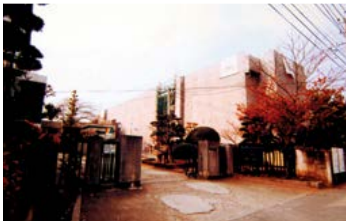
校舎工事 (平成 14 年アルバム)
